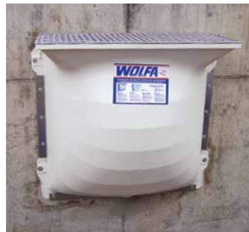
Doświetlacz wodoszczelny PROFi z korpusem zamkniętym od dołu
