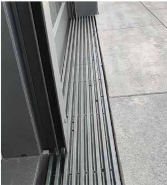
Bei diesem Anwendungsbild wurde die Rinne auf Drainagemörtel gesetzt und aufgebohrt (Bild AquaStop Drain 150)
